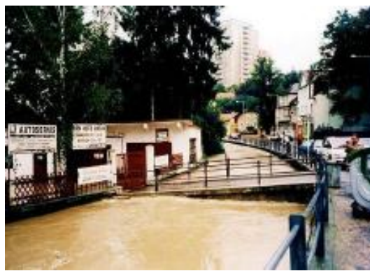
Botič 2002, regulované koryto v Záběhlické ulici
